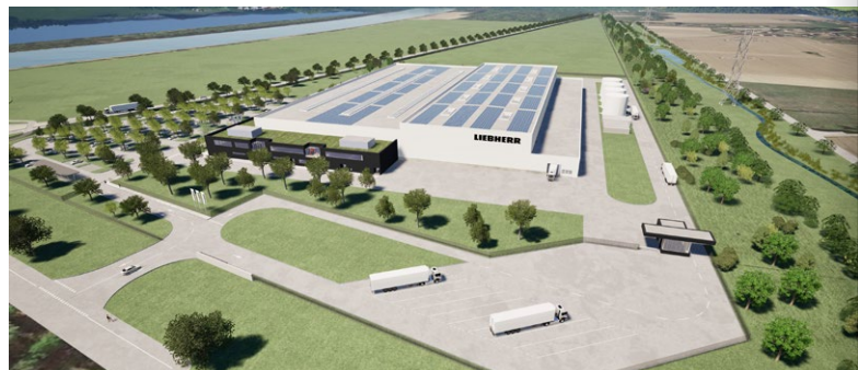
Vue aérienne de la façade nord du site de Nambsheim. Sur la droite du hall, le sas de chargement est visible. La logistique occupe le hall le plus haut. Dans sa continuité, le hall doté d'une moindre hauteur abrite production, située à proximité des bureaux, en couleur sombre.
